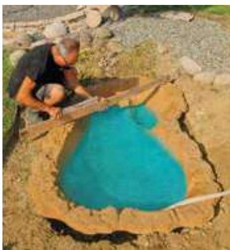
Posizionamento del laghetto in vetroresina
