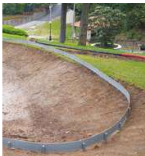
Installazione in bolla del bordo per il laghetto
