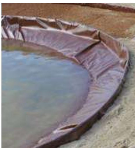
Telo posizionato e fissato sul bordo
