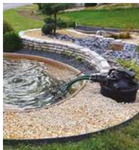
Lavoro ultimato con installazione filtro esterno
