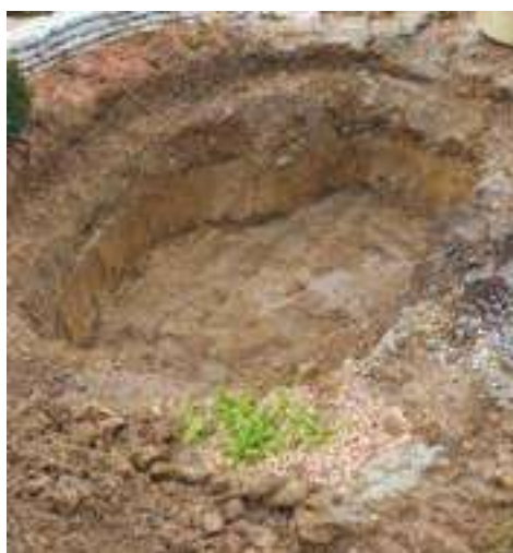
Scavo con scalino per laghetto in vetroresina
